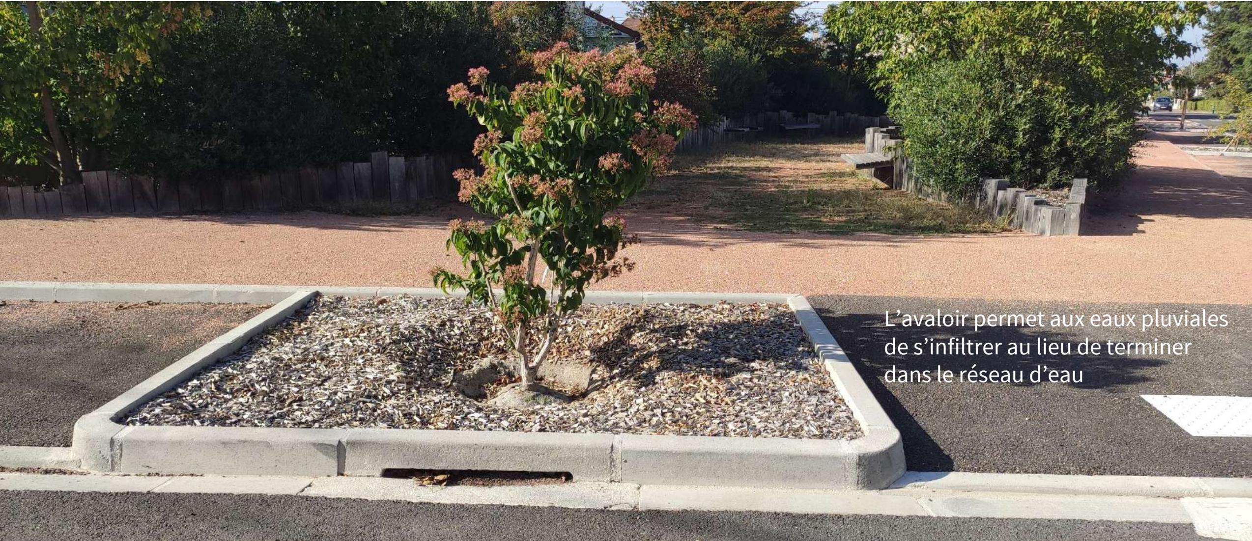
L'avaloir permet aux eaux pluviales de s'infiltrer au lieu de terminer dans le réseau d'eau
